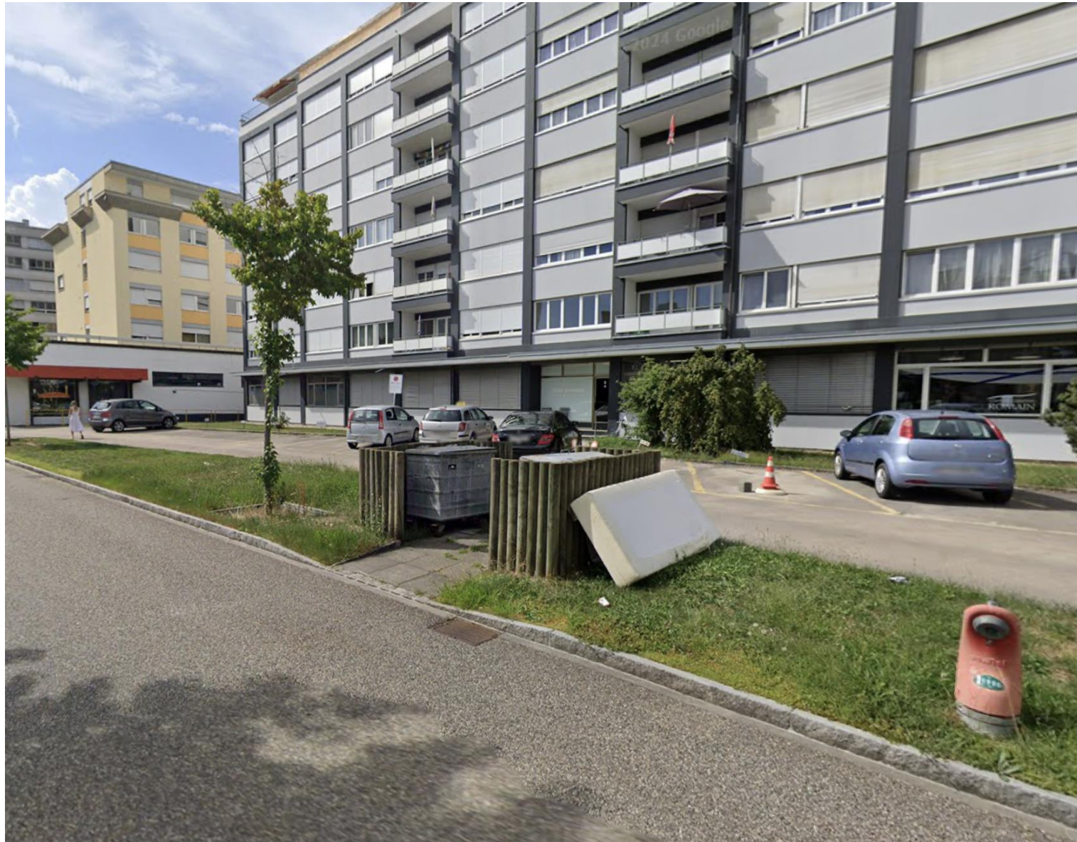
Rue de l'Industrie, Delémont
